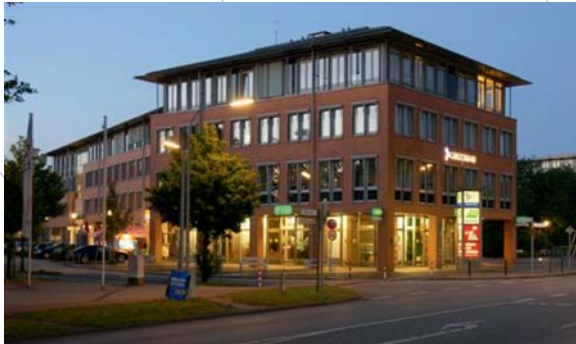
Außenansicht der MA HSH
